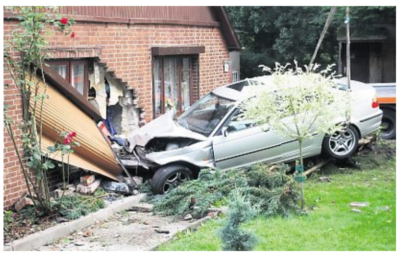
Beim Aufprall schlug dieser silberfarbene BMW ein Loch in der Hauswand. Der Wagen war im Ortsbereich von Holte-Spangen in einer leichten Linkskurve von der Fahrbahn abgekommen. Foto: Koppe
